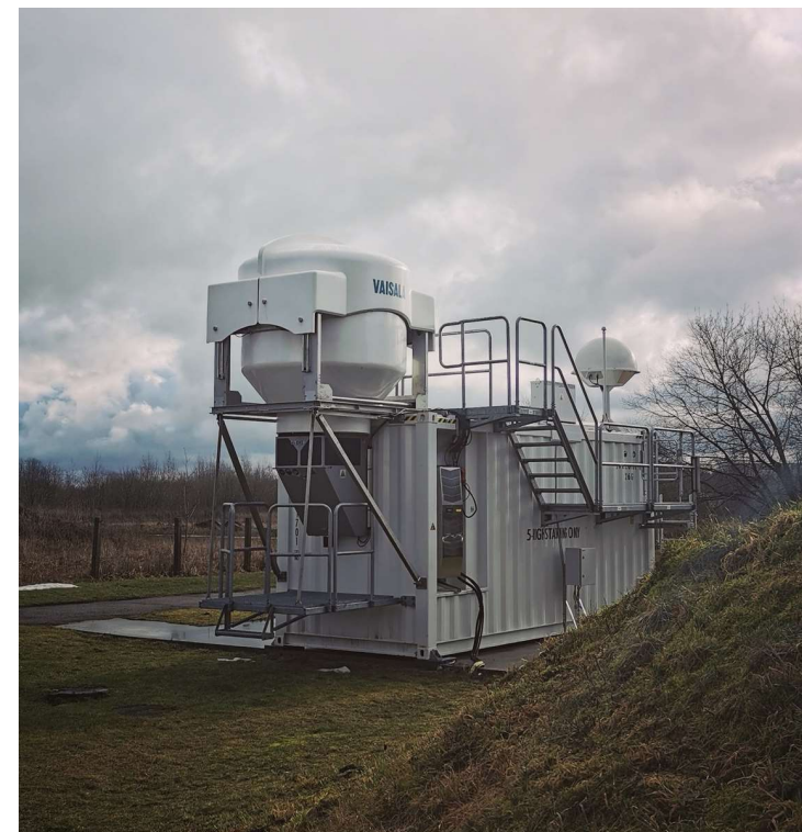
Tallinn-Harku aeroloogiajaama automaatne raadiosondijaam (Ilmateenistus, 2020).
